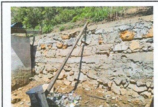
Foto 9: Muro de contención o perimetral. 3 y 22 mts.
