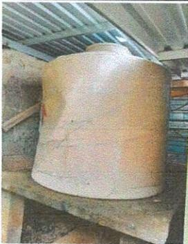
Foto 3: Instalación de tinaco de 2, 500 Lts y accesorios.
