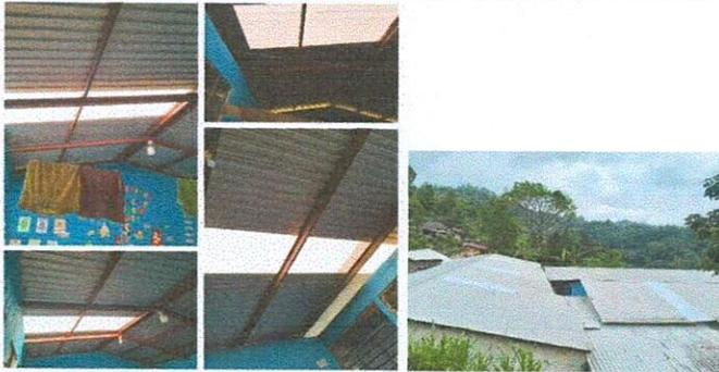
Foto1: Colocación de lámina troquelada lamiluz. 4 aulas.
