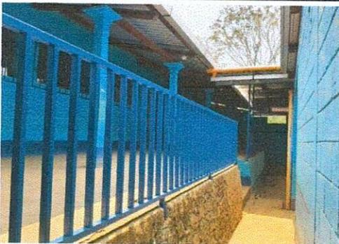
Foto 5: Levantamiento de muro de seguridad metálico.
